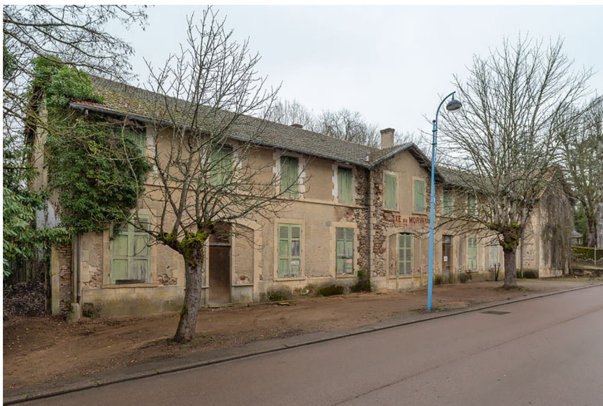
Façade principale, vue depuis le sud-ouest.
