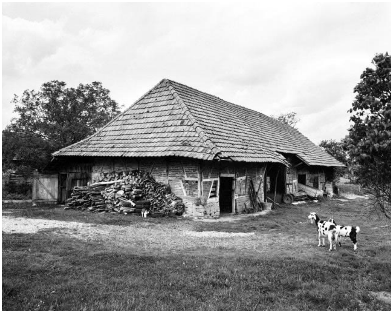
Bâtiment d'exploitation : façades antérieure et latérale gauche.
