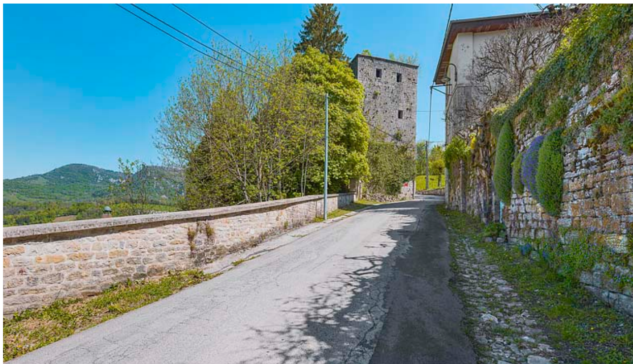
Vue depuis la rue de Chambenoz.
