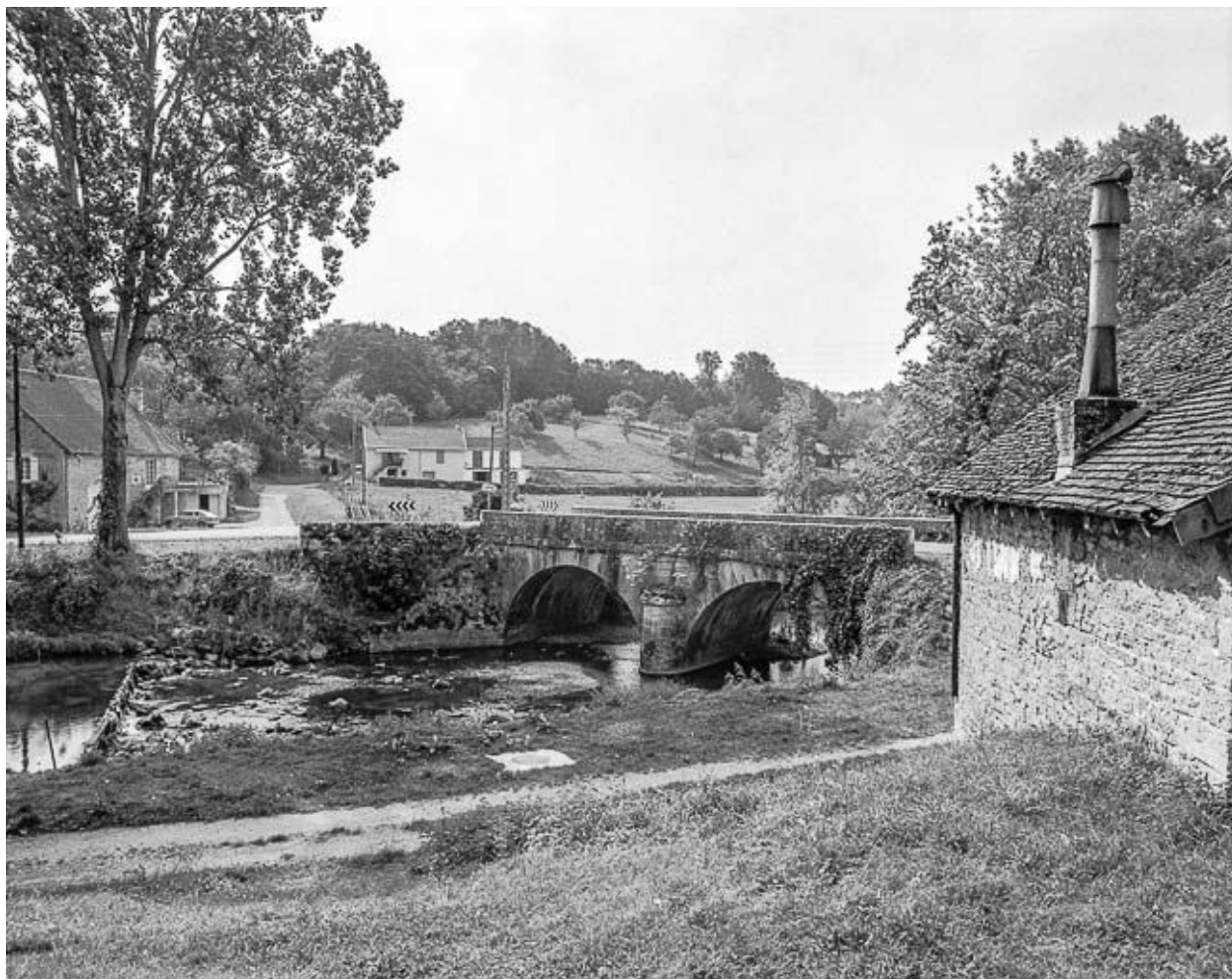
Chilly-le-Vignoble : pont sur la Sorne.
