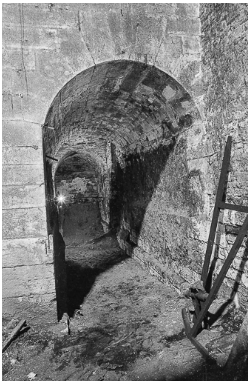
Base du haut fourneau en 1979. Galerie ouest.
