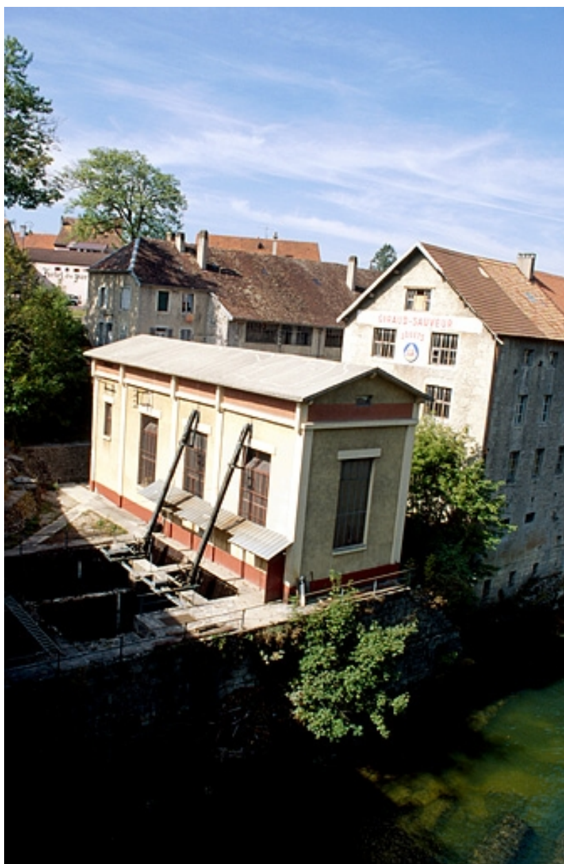
La centrale hydroélectrique.
