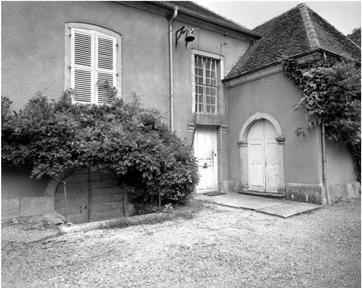
Façade antérieure du logis : partie droite.
