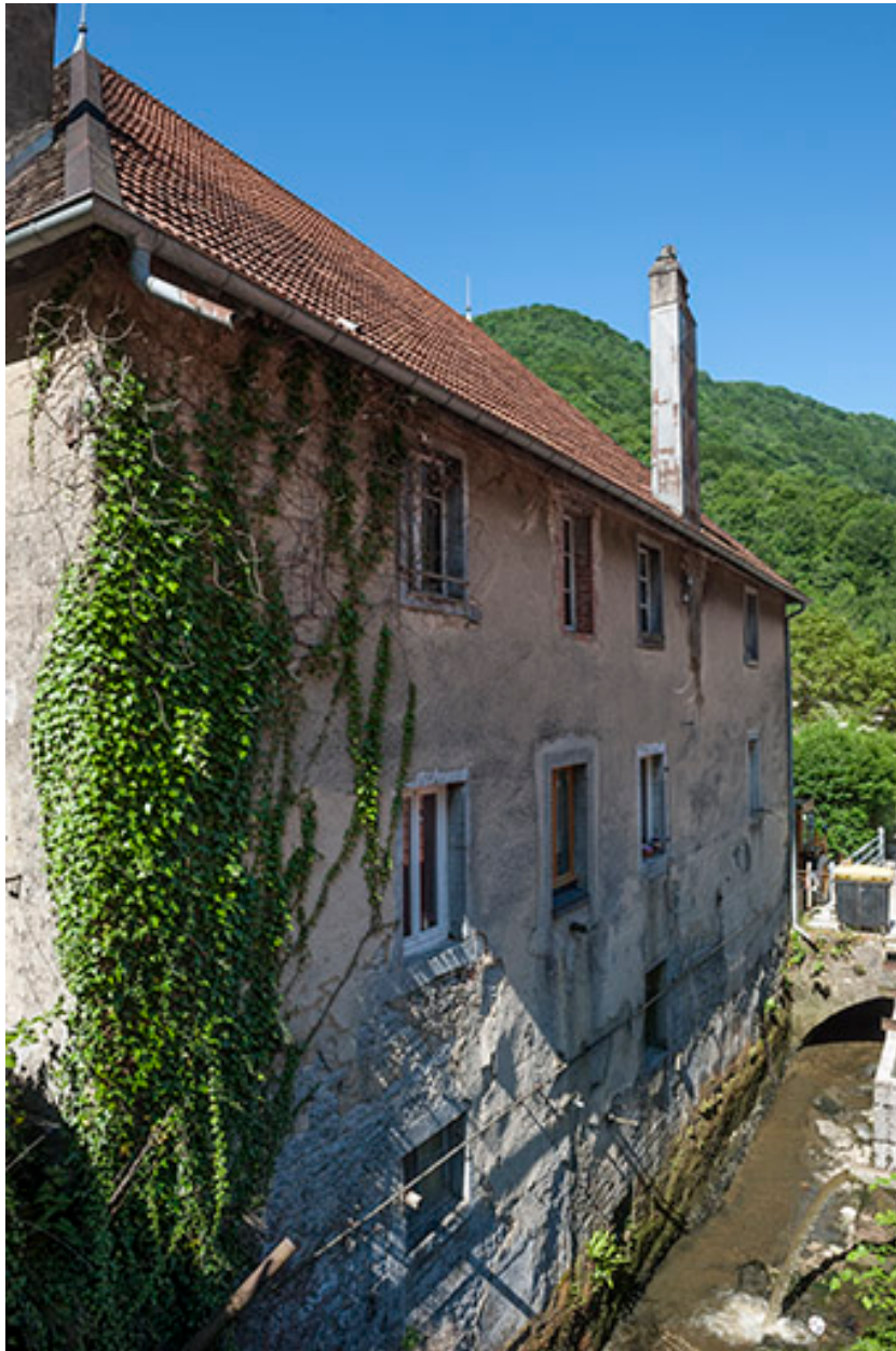
Façade nord du logement (ancien atelier).
