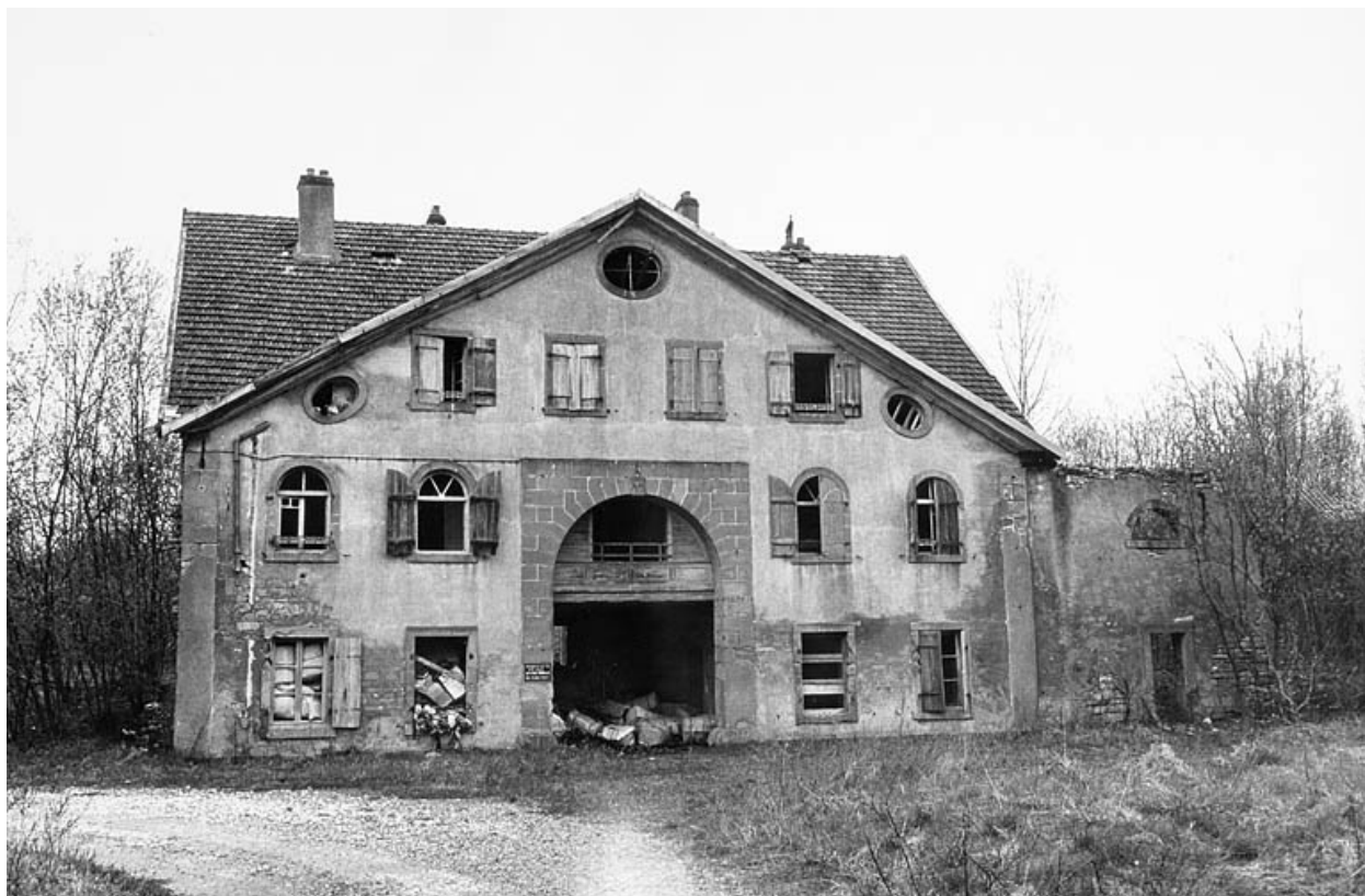
Bâtiment d'entrée ouest en 1977. Façade antérieure.
