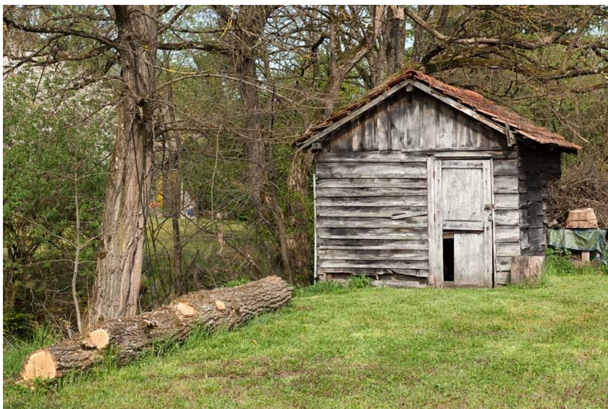
Scierie Courtot, rue du Pont : dépendance en pan de bois et essentage de planches.
