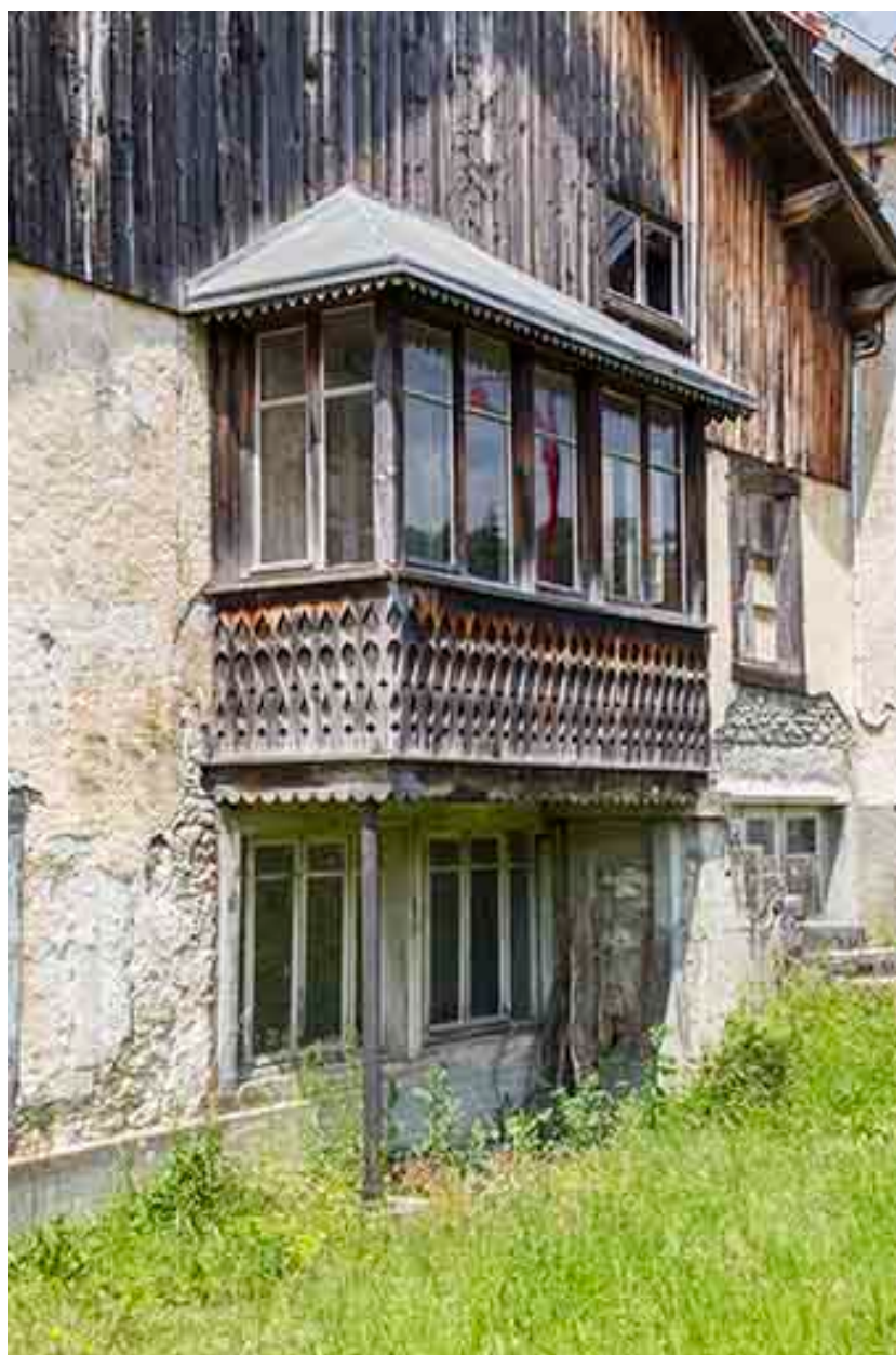
Logement d'ouvriers : porche.
