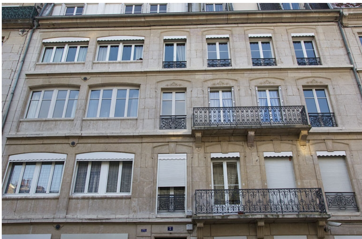
Vue d'ensemble de la façade, de face.
