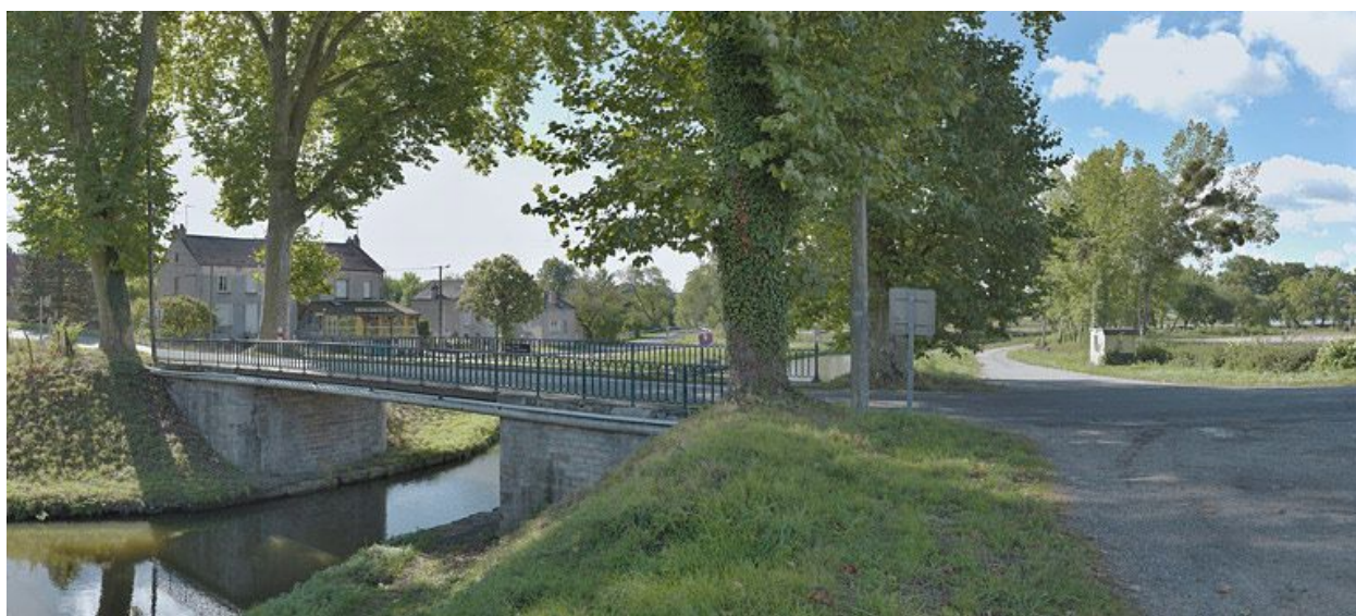
Le pont vu d'aval. Café en face.
