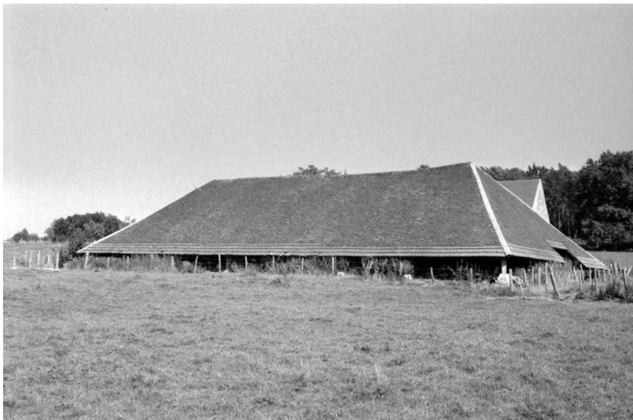
Halle de séchage, depuis l'ouest.
