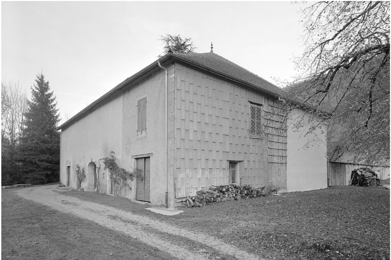
Face sud-ouest et façade postérieure.
