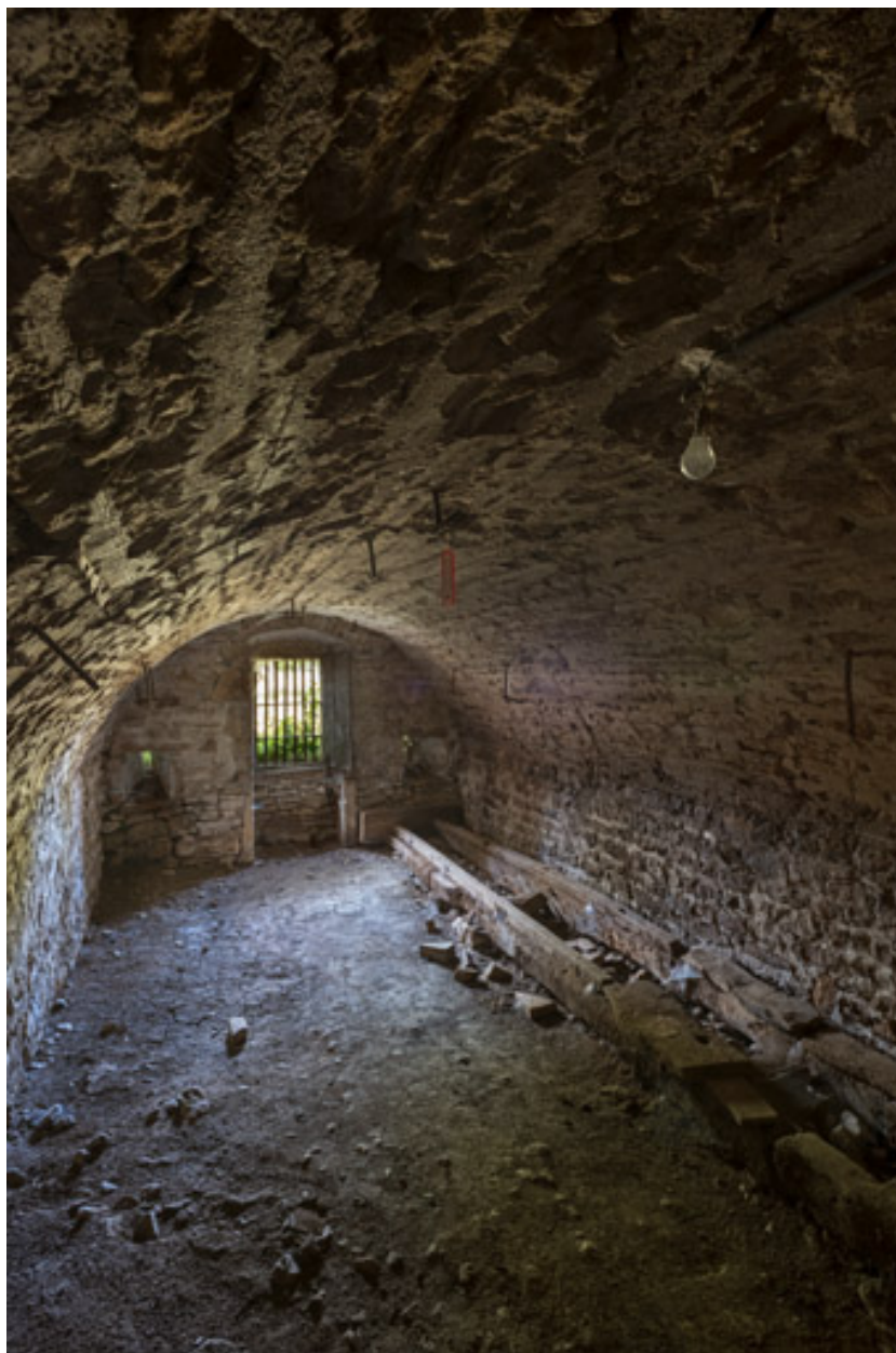
Vue intérieure de la cave
