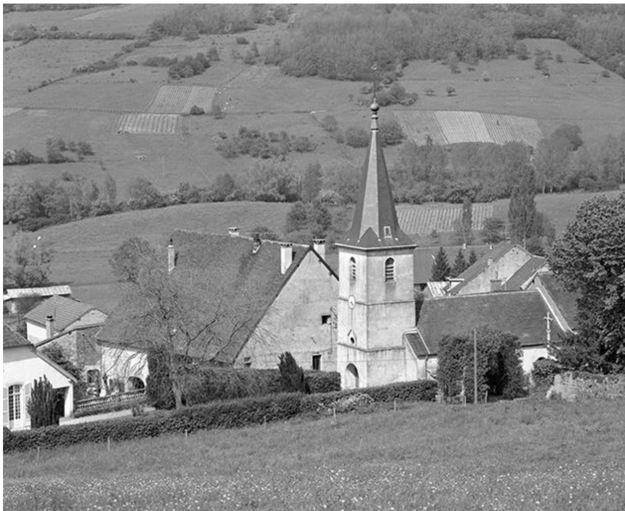
Façade antérieure et face droite.
