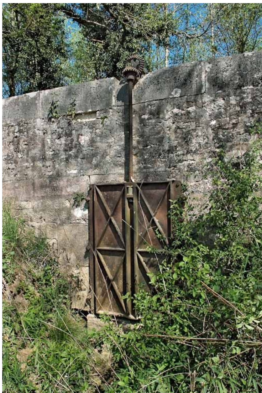
Vanne de l'aqueduc ménagé dans la route-digue.
