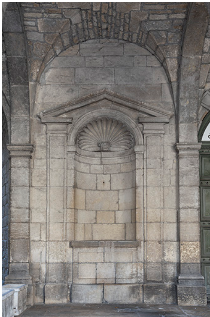
Façade antérieure du parvis. Niche sud.
