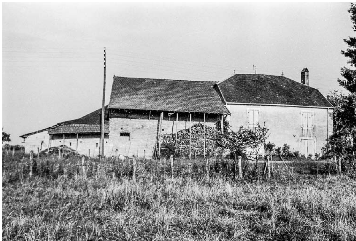
Ferme cadastrée 1969 AD 171-172 : façade postérieure.
