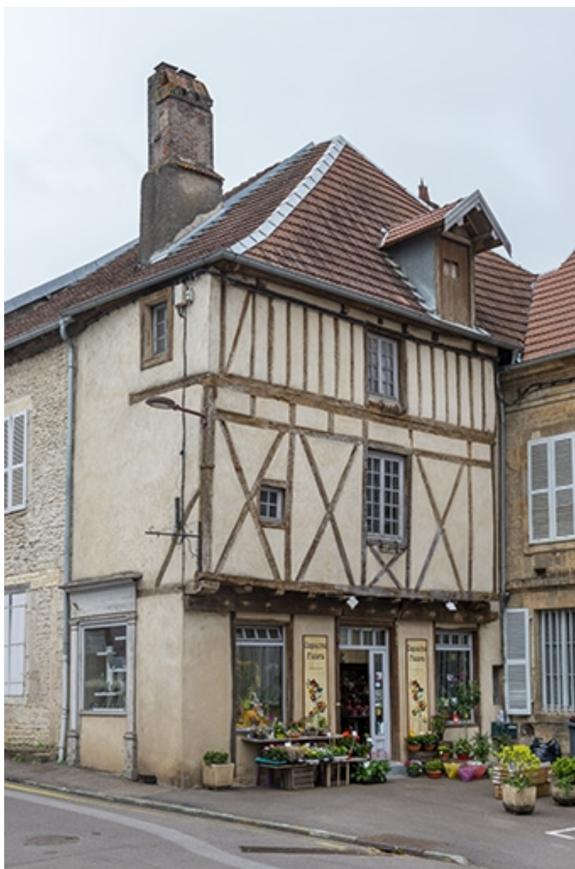
La façade de trois quarts.
