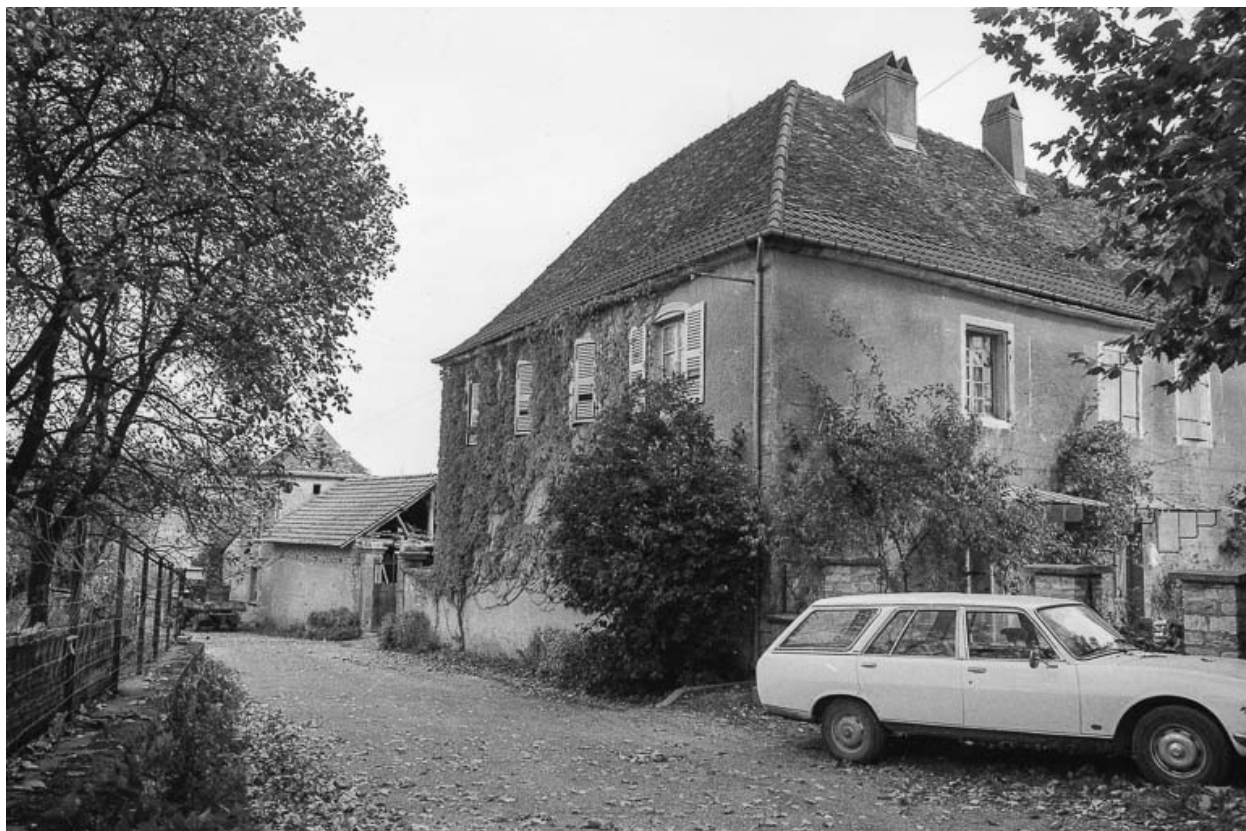
Façades latérale droite et postérieure.
