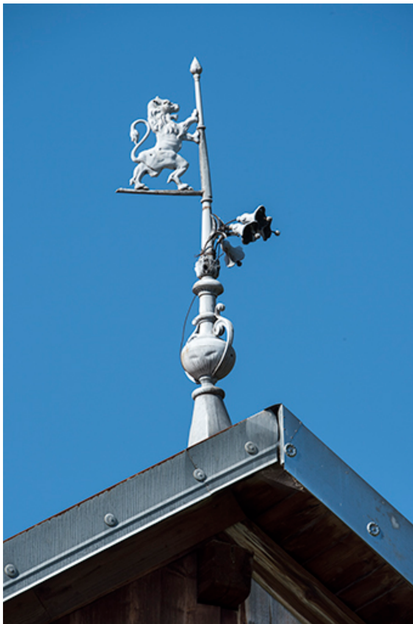
Façade latérale droite : épi de faîtage.
