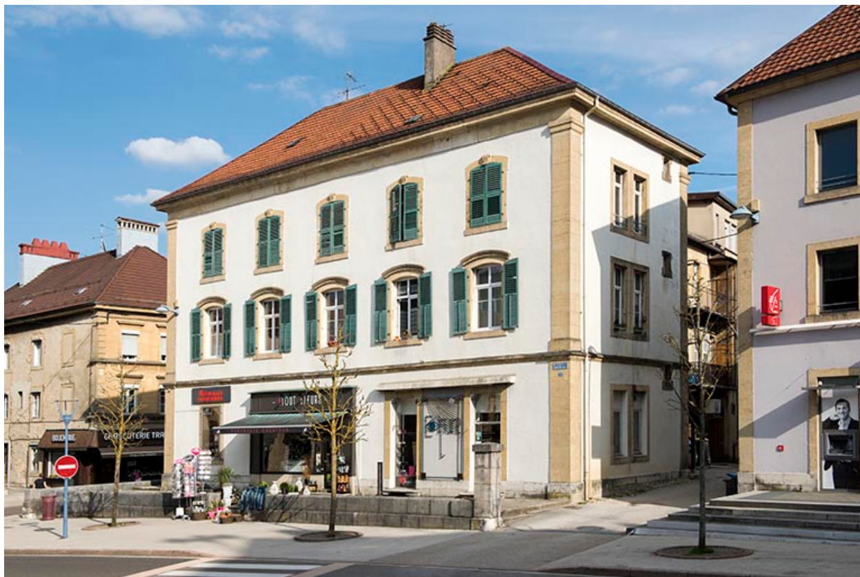
Façades antérieure et latérale droite.
