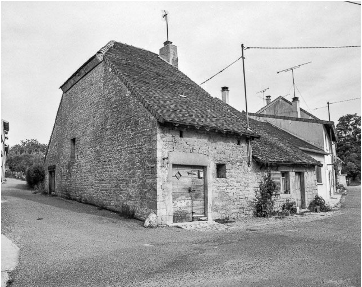
Façades antérieure et latérale gauche.
