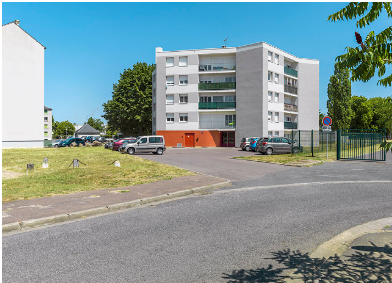
Bâtiment X, façades sud-ouest.
