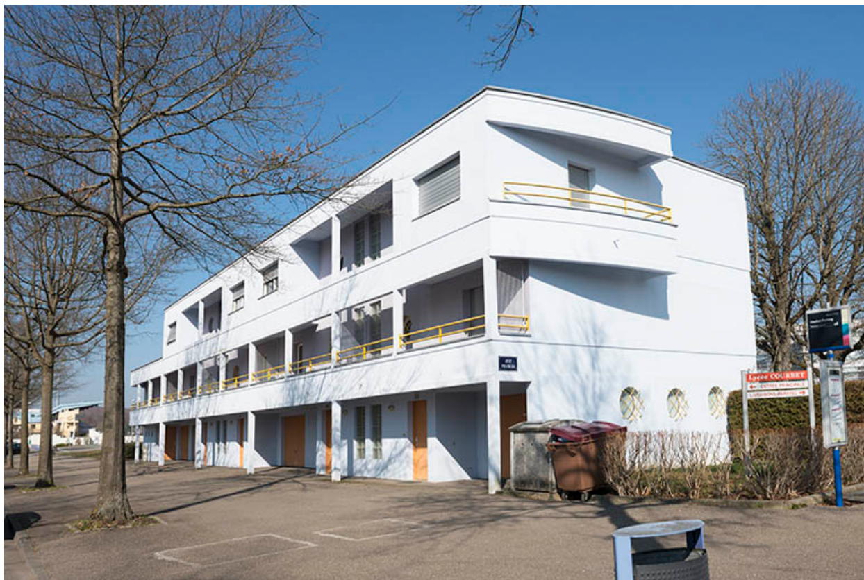
Angle sud-ouest des logements sud-ouest.
