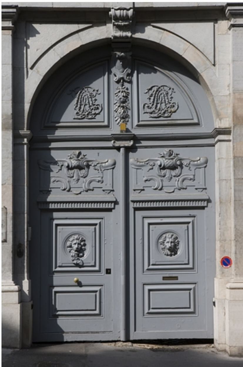
Portail d'entrée : vue d'ensemble.
