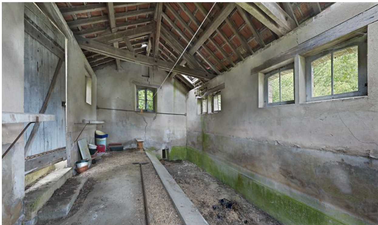
Intérieur du lavoir.
