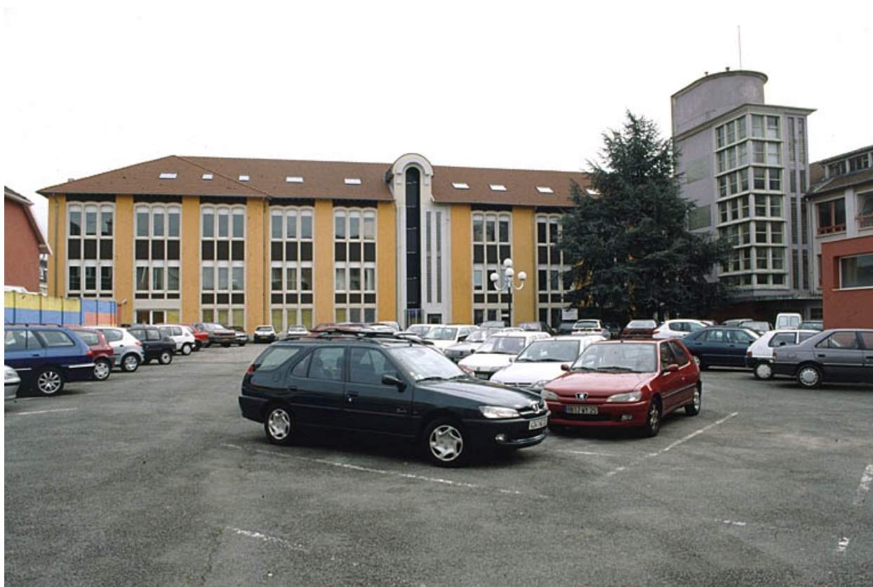
Façade ouest de l'atelier depuis la cour.
