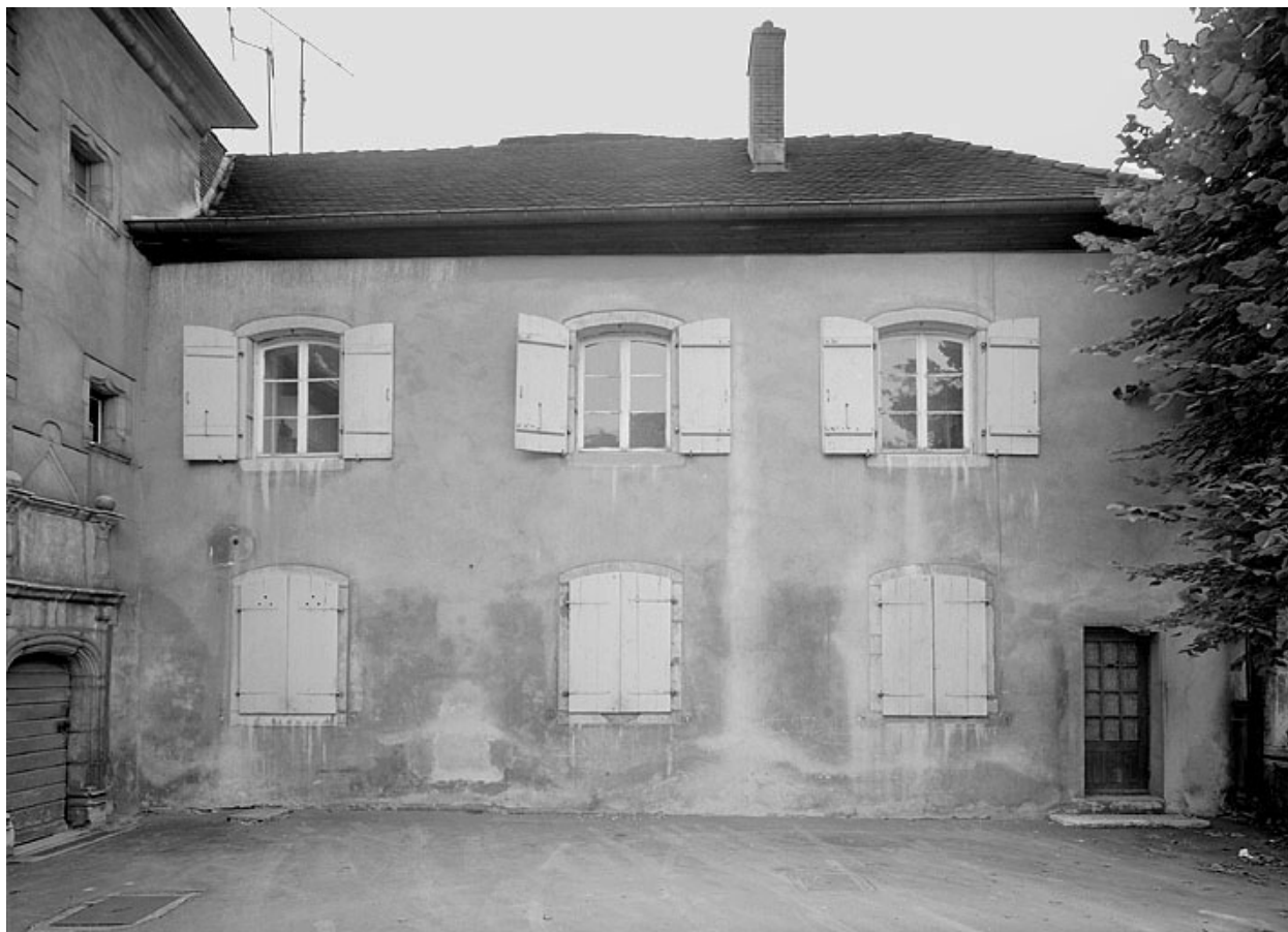
Aile droite. Façade sur la cour.
