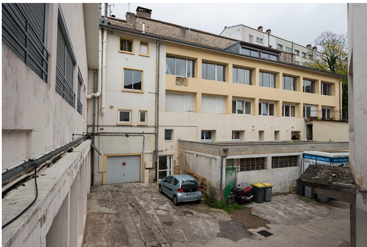
Façade ouest d'un atelier sur cour (4B).
