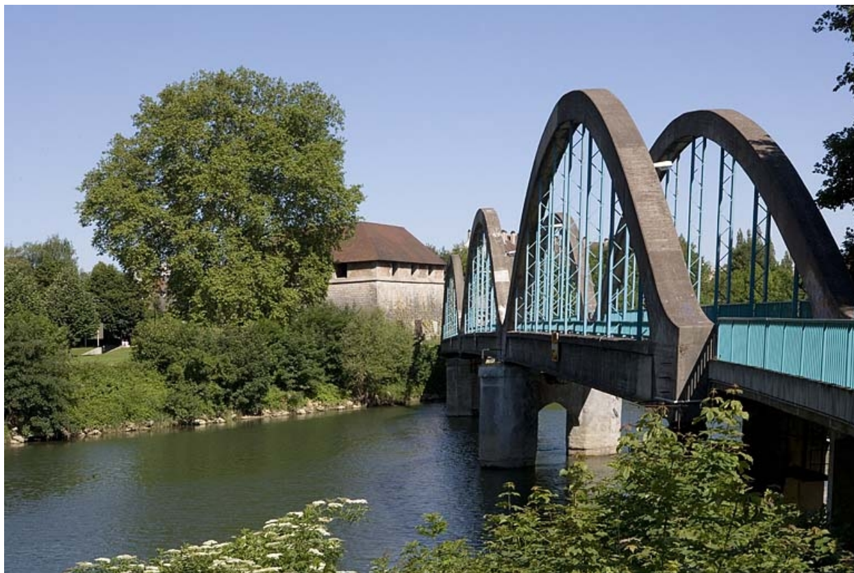
Face amont depuis la rive droite.
