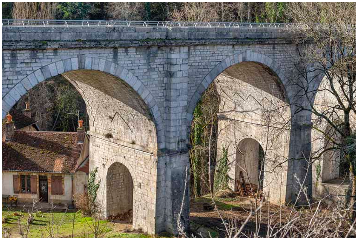
Vue sur les arches, depuis le nord-est.
