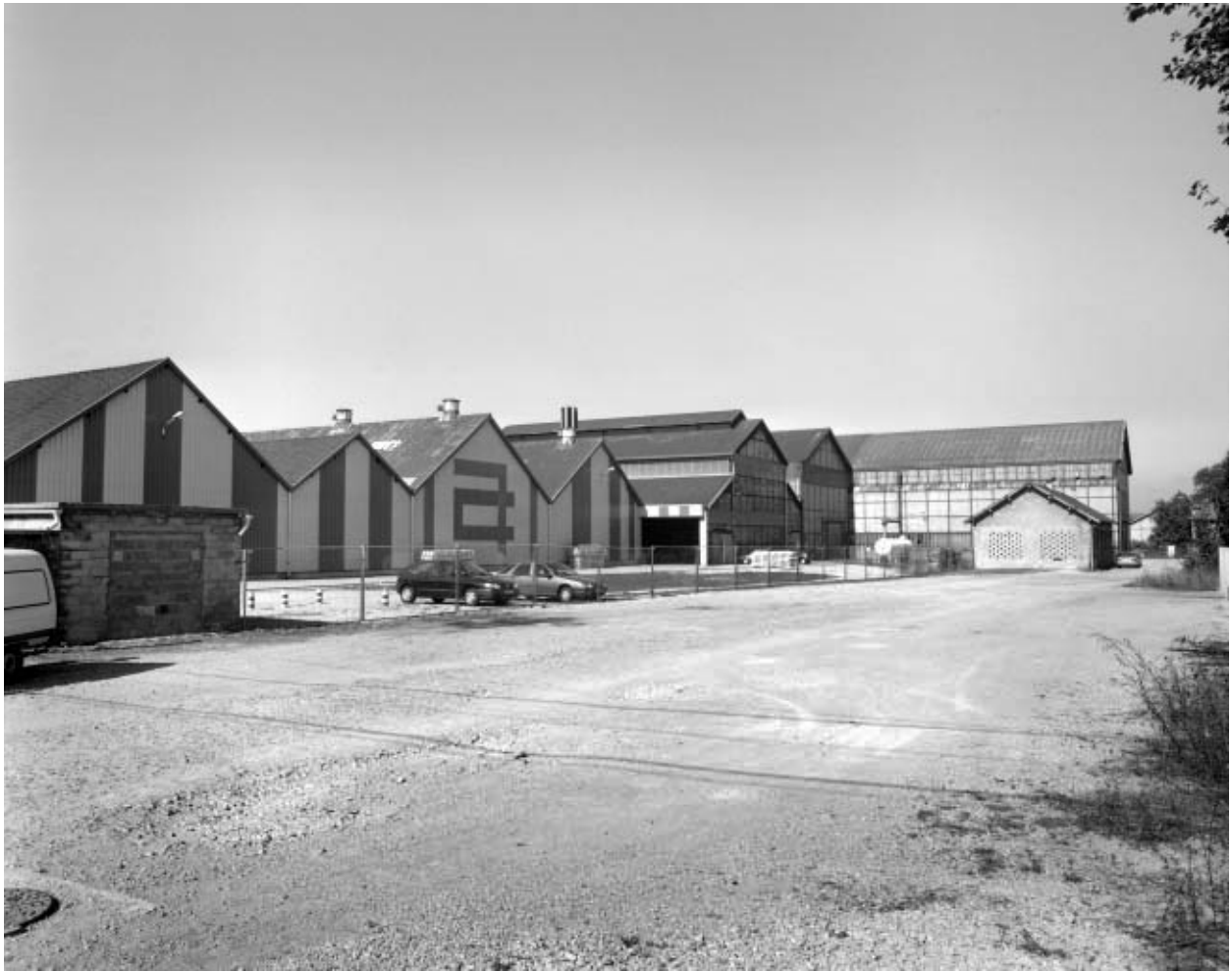
Façades postérieures des ateliers de l'ancienne forge.
