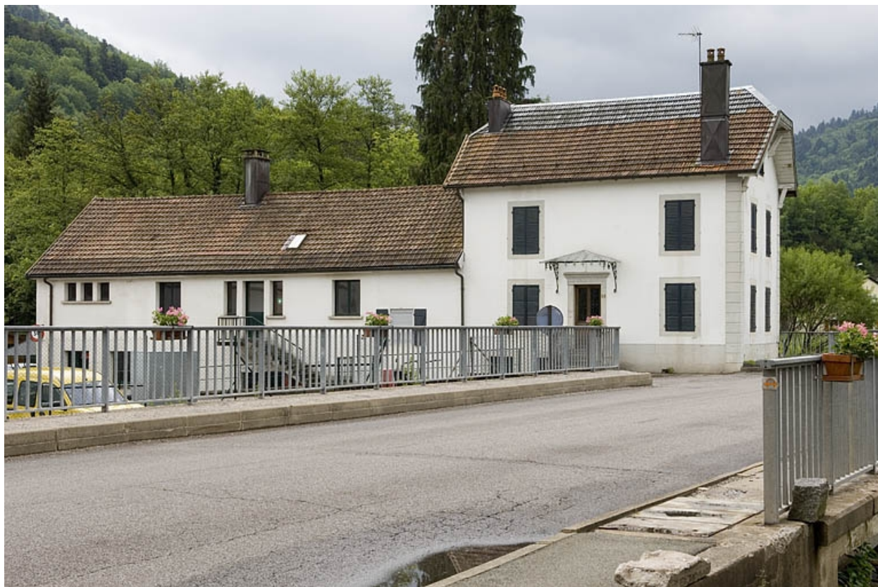
Le bâtiment de l'ancien moulin.
