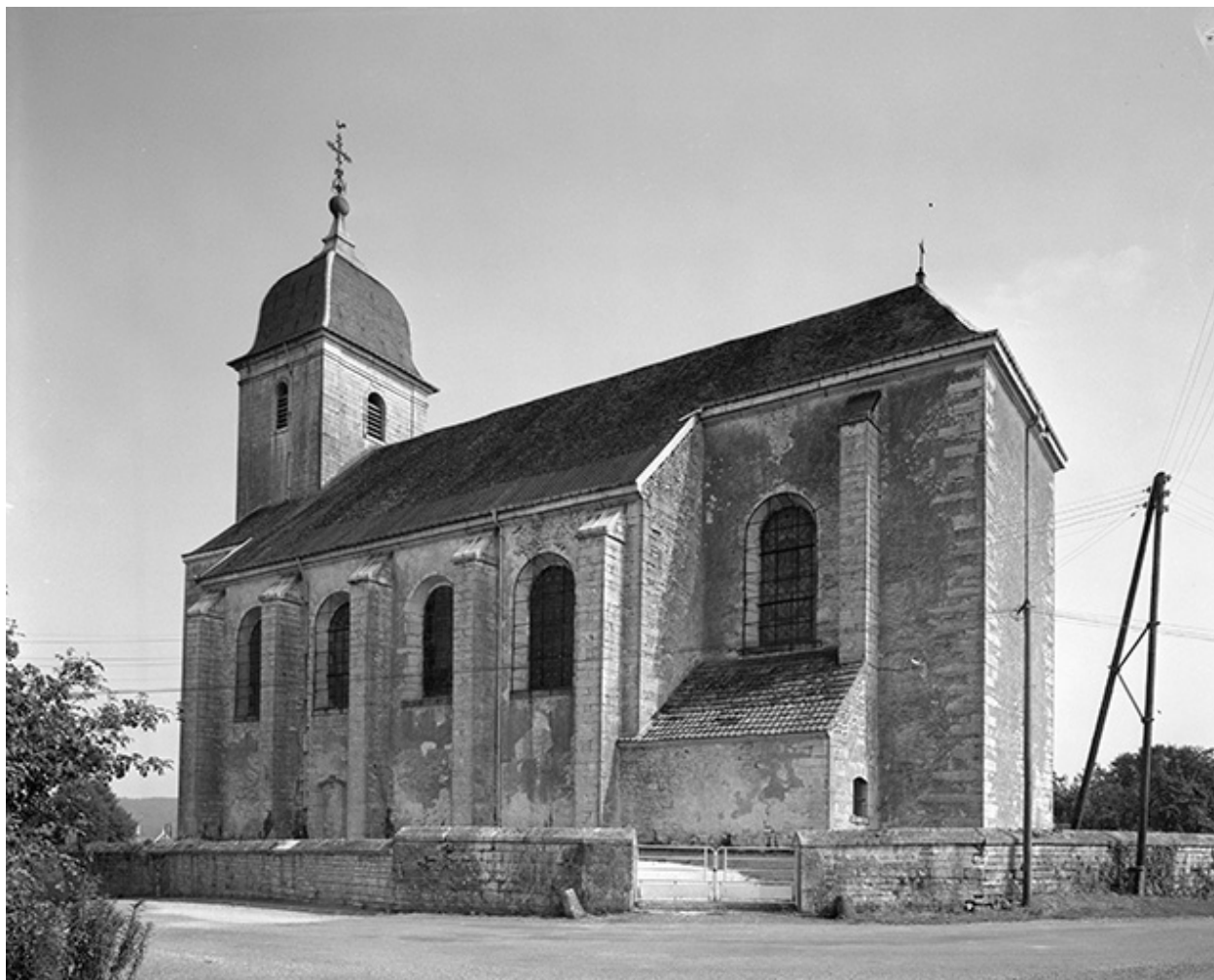
Façade latérale droite.
