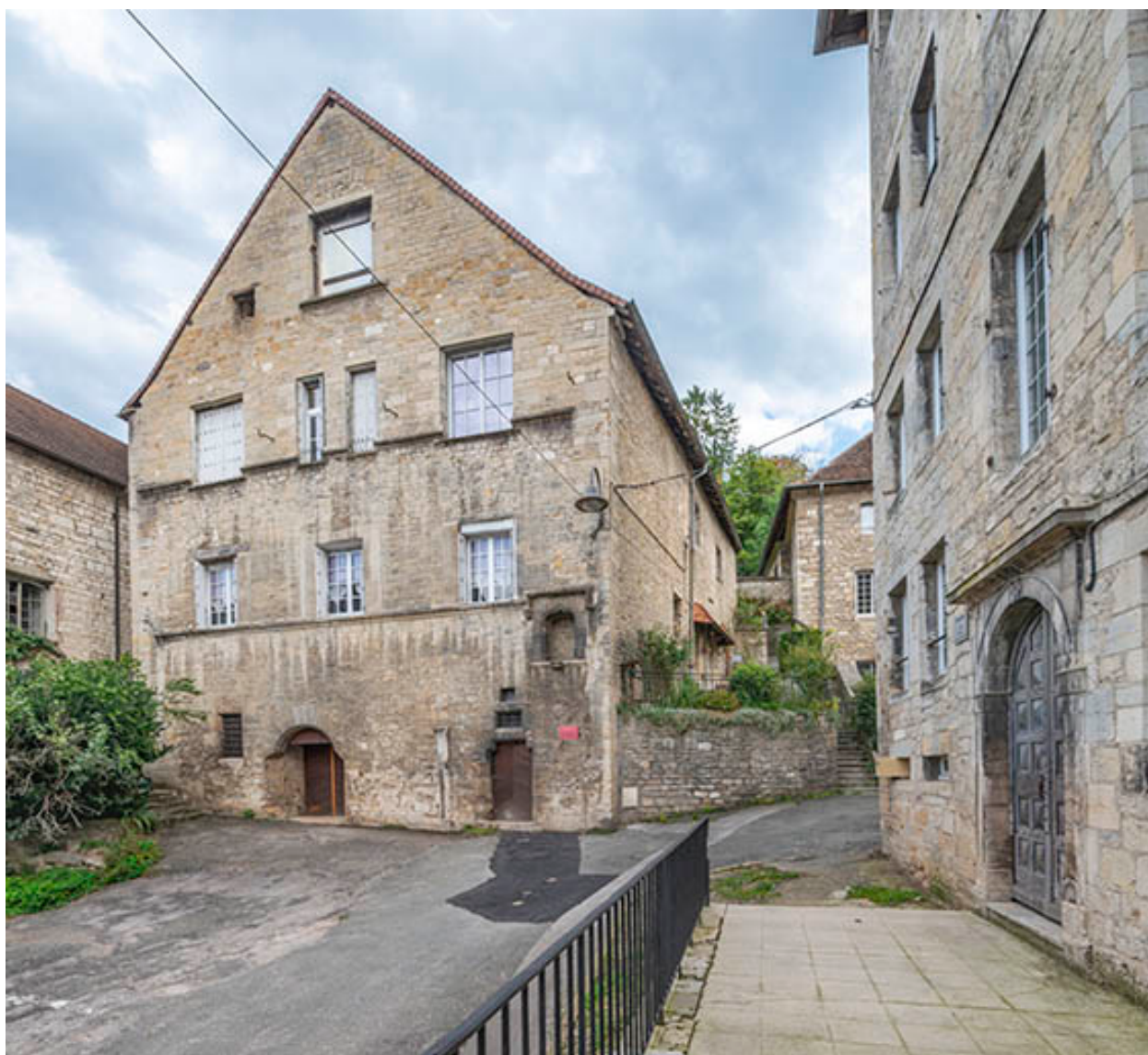
Façade ouest vue de trois quarts droite.
