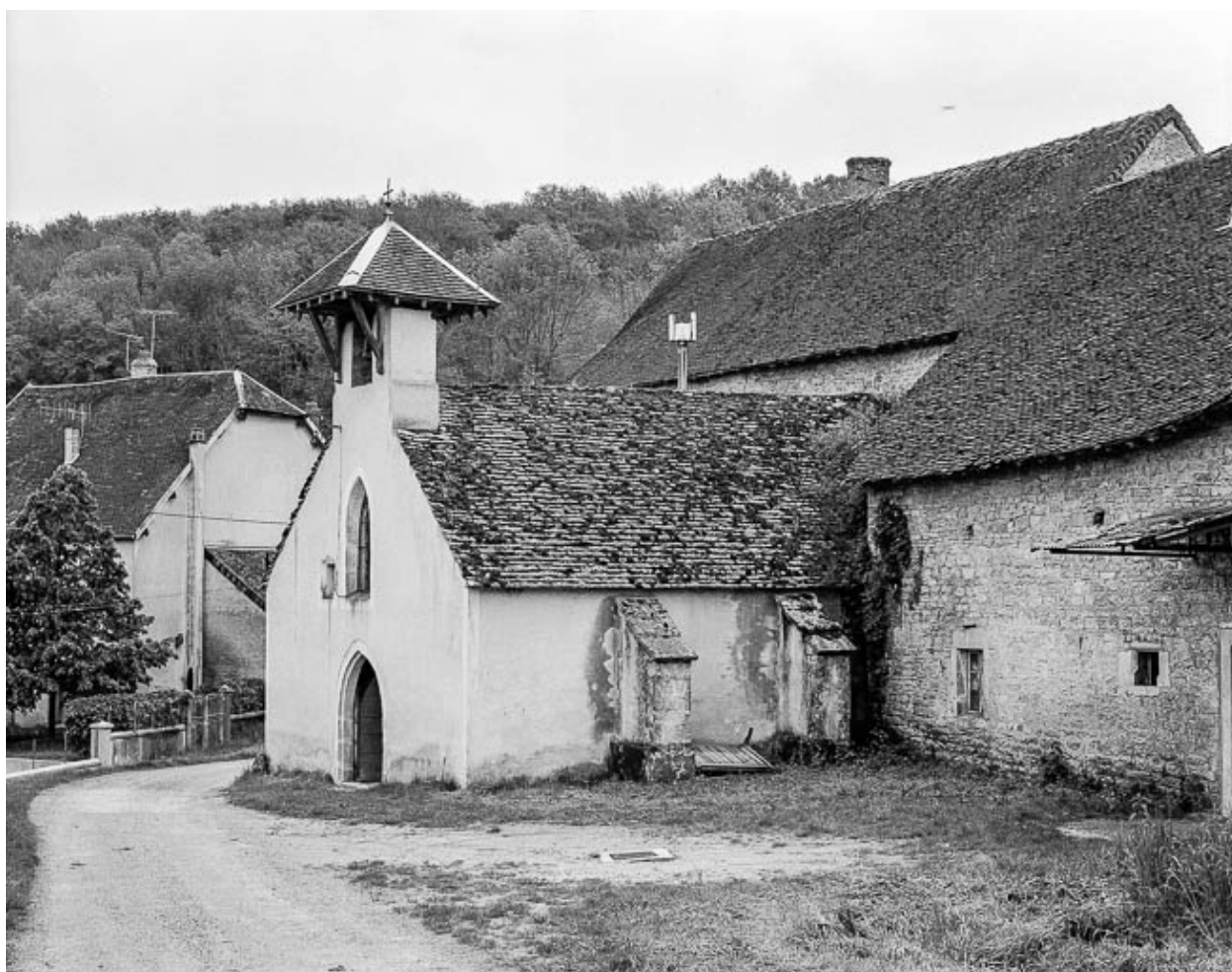
La chapelle, façade antérieure et face droite.
