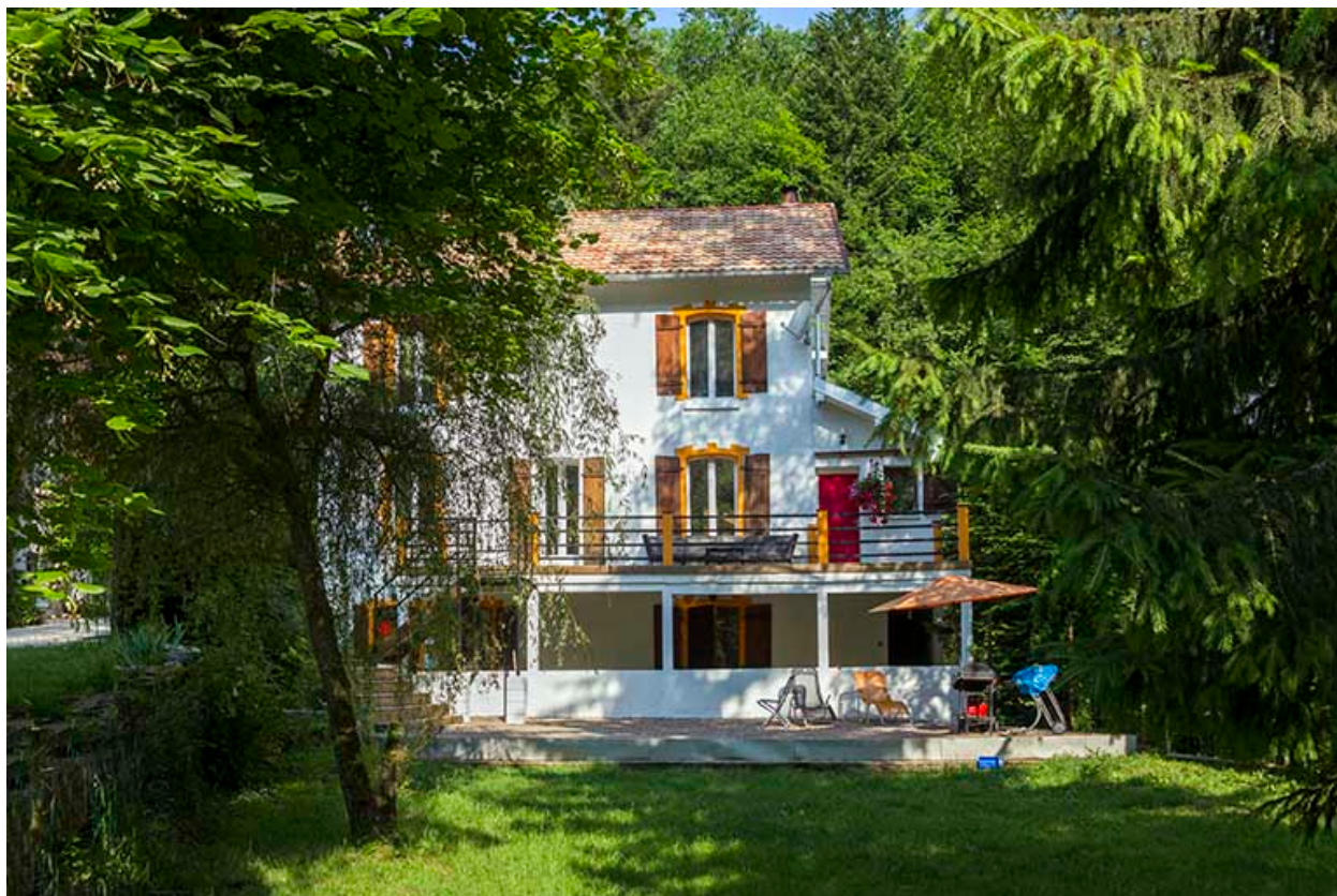
Logement de contremaître : façade postérieure.
