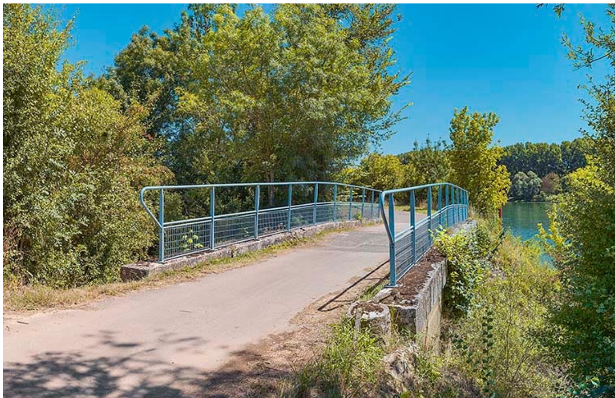
Vue d'ensemble, d'aval.
