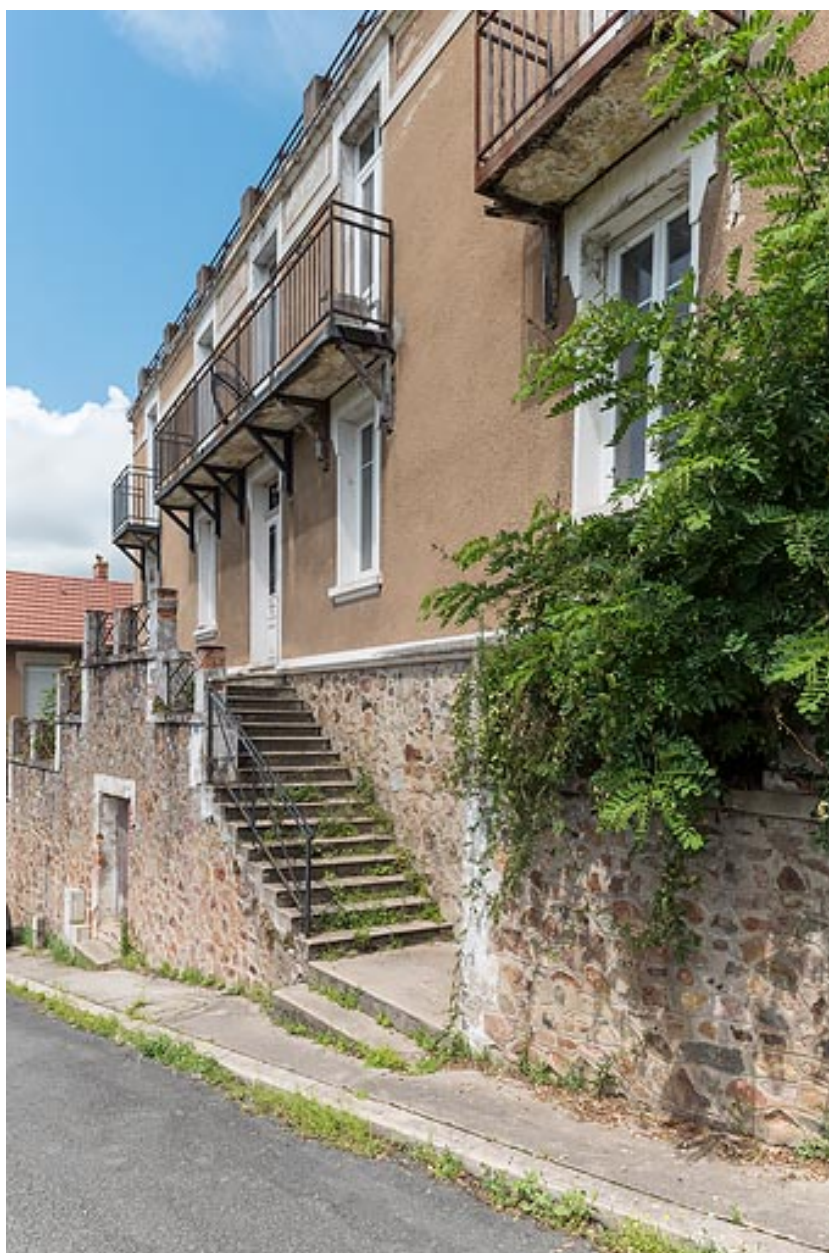
Façade de l'extension ("annexe").
