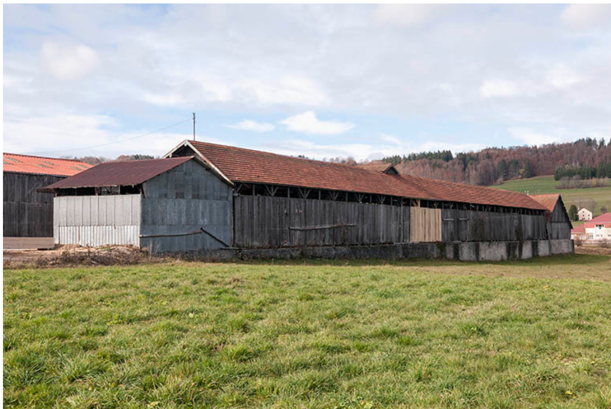
Hangars de stockage.
