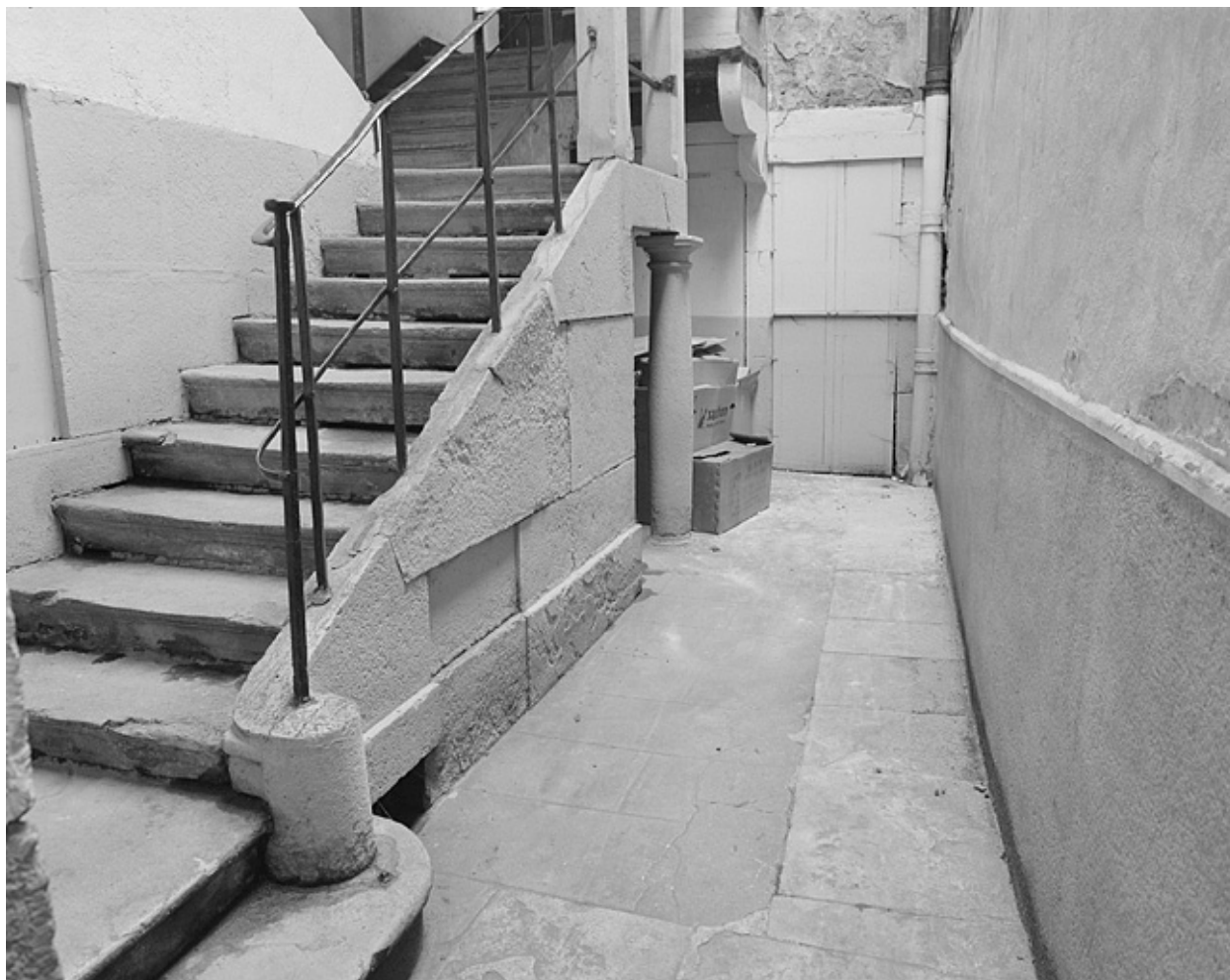
Maison, 26 rue du Commerce, escalier sur cour.
