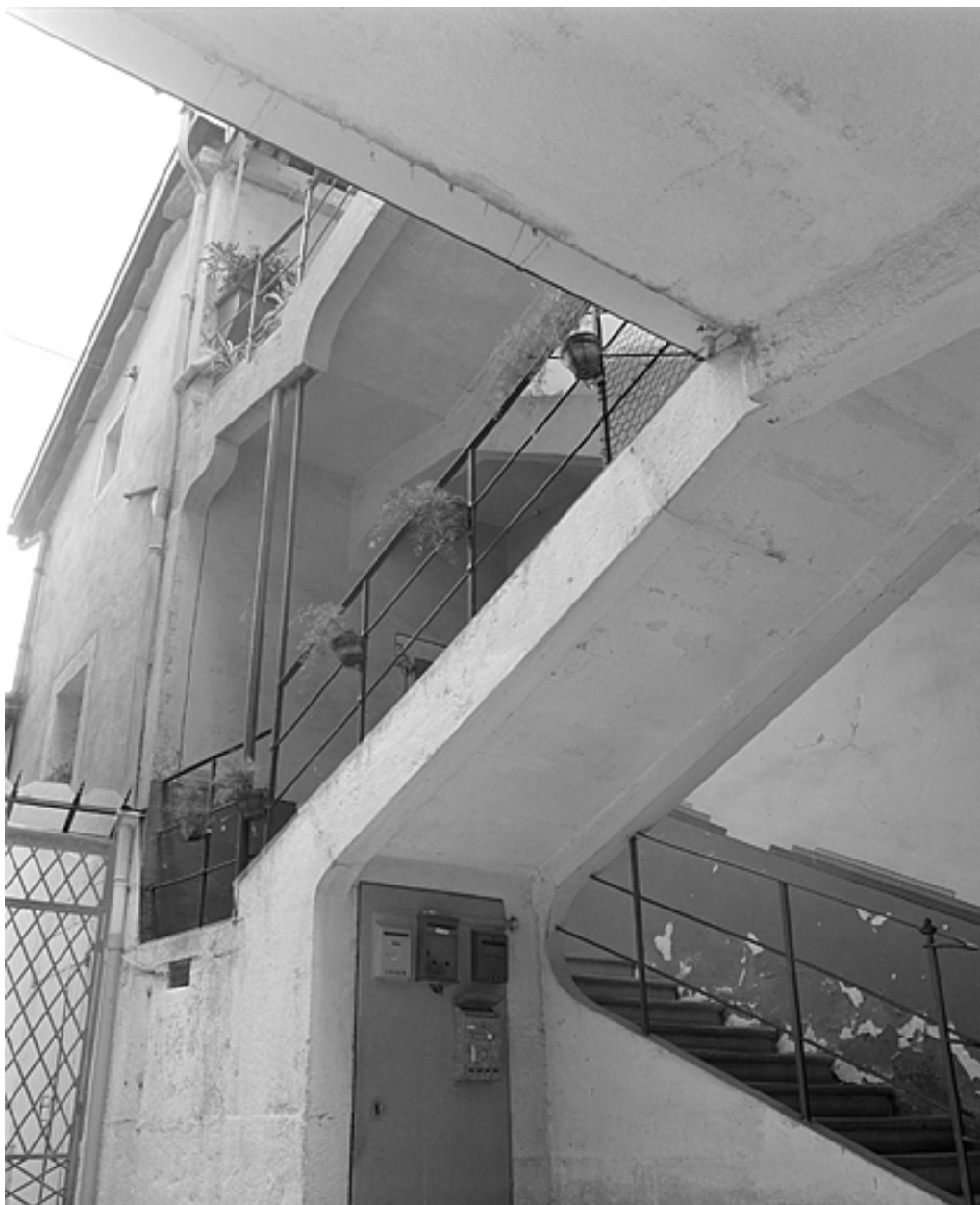
L'escalier ouvrant sur la cour.
