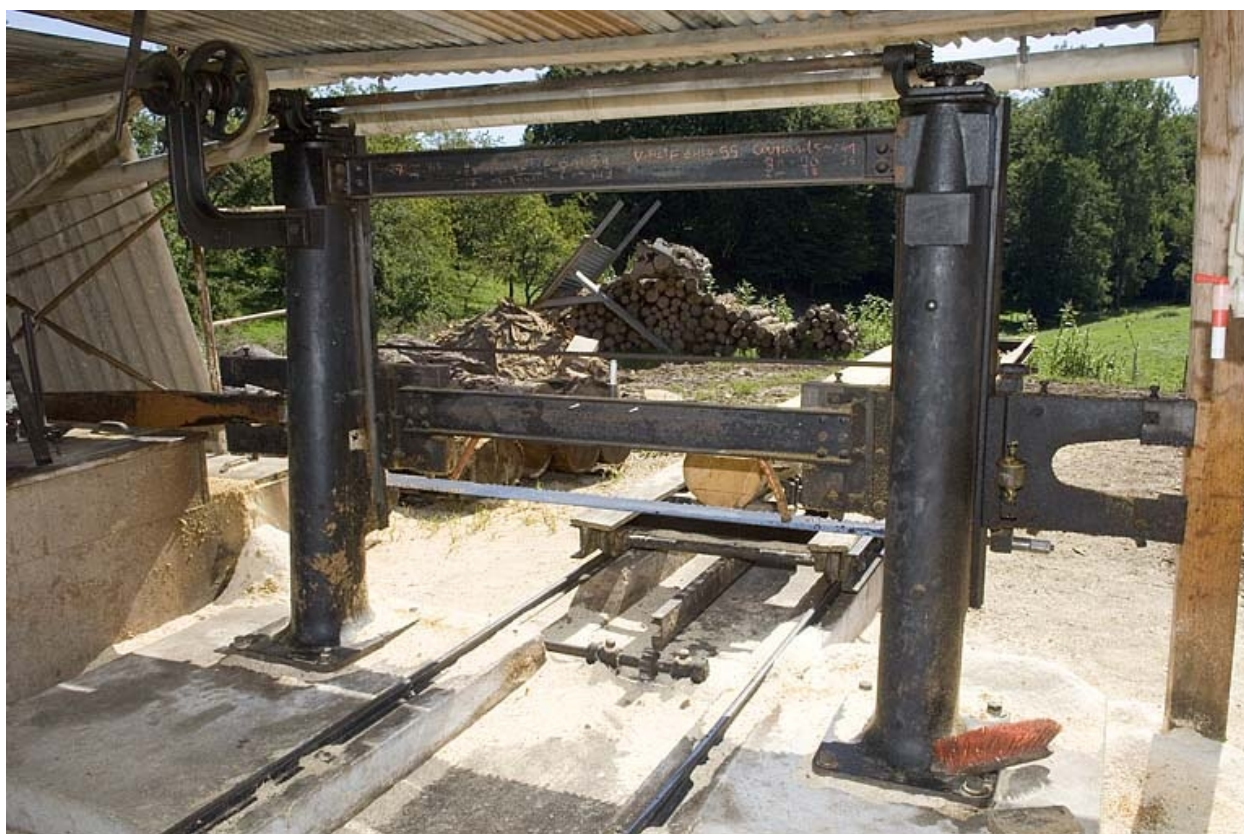
Moulin à farine puis scierie, Aillevillers-et-Lyaumont (hameau de la Louvière) : châssis de scie monolame horizontale.
