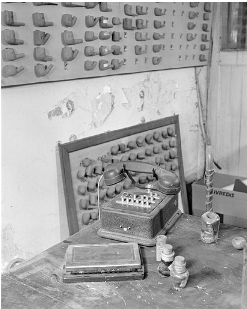
Vue d'ensemble du poste de bureau.
