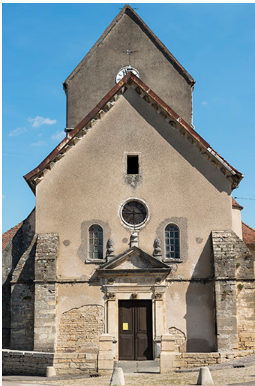
Vue avant restauration (2016).
