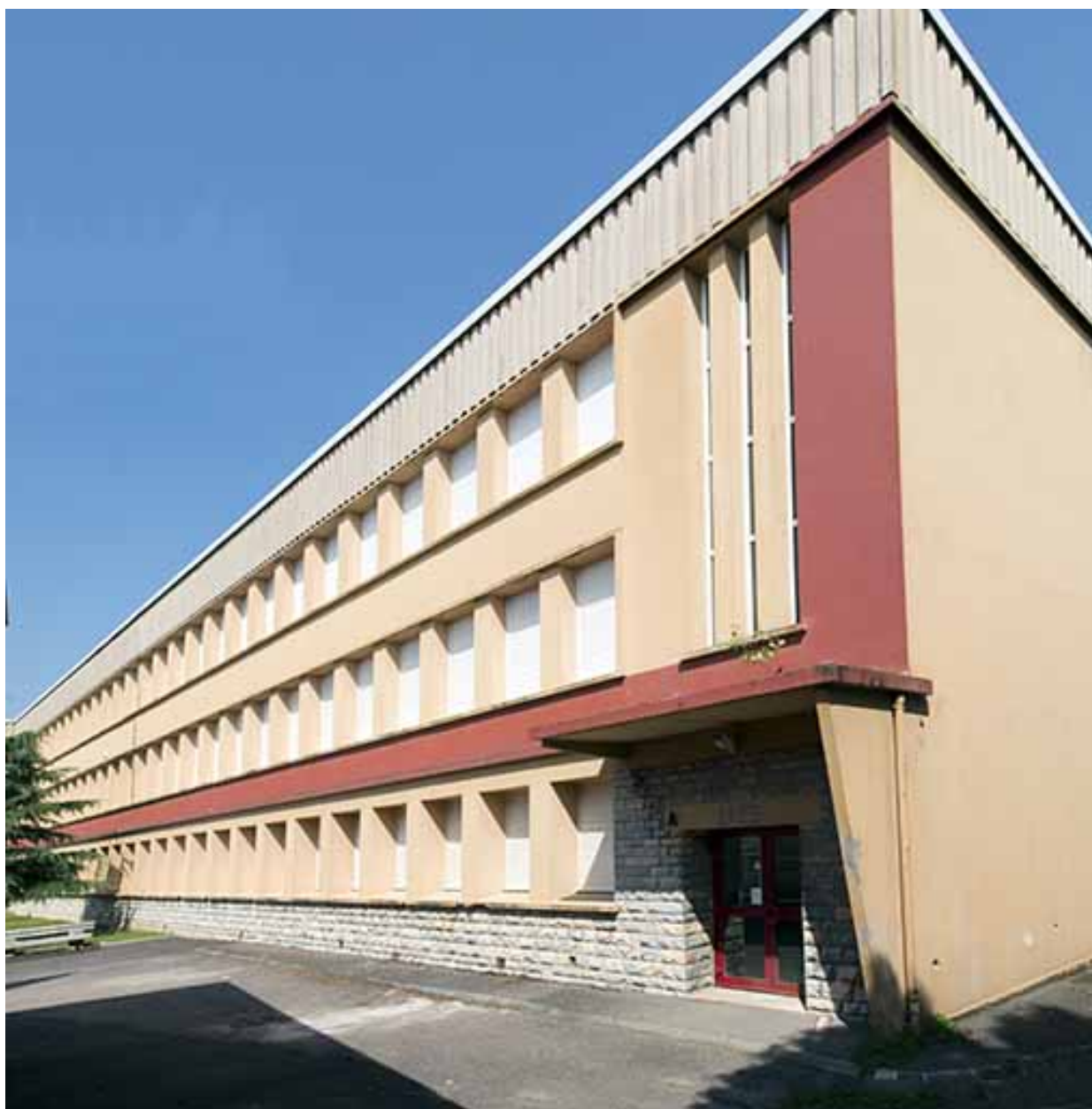
Angle sud-est de la barre d'externat nord.
