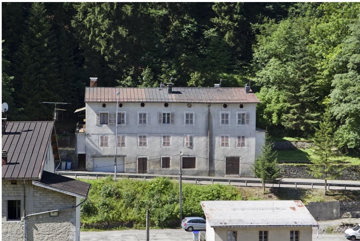
Vue d'ensemble plongeante, depuis le nord-est.
